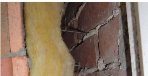
Außenwand: Das Originalmauerwerk wurde von innen mit mineralischer Dämmung und Poroton T8—Dämmsteinen versehen, © Henning Pape
