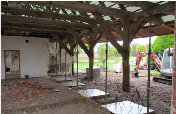
Eine durchgehende Bodenplatte sorgt für gute Dämmung nach unten, © Henning Pape
