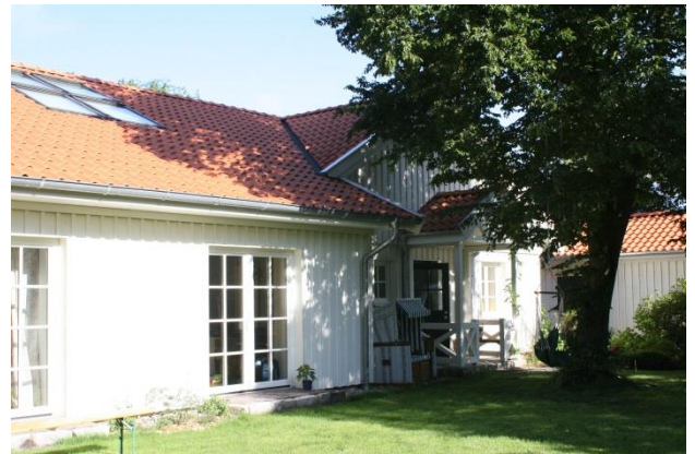
Familie Nieper: Nach der Sanierung
