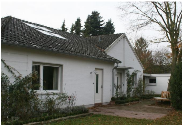
Familie Nieper: Vor der Sanierung
