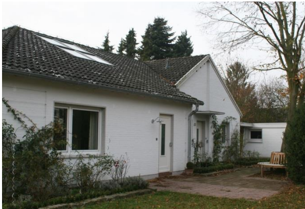
Familie Nieper: Vor der Sanierung
